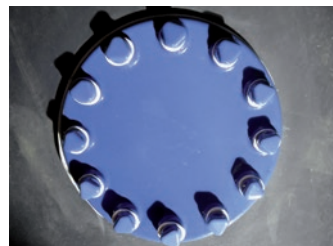
⌚ 3: RepCap-Verschraubung zum Befestigen eines emaillierten EmPads / RepCap screw connection to attach a large sized glass-lined EmPad repair element
