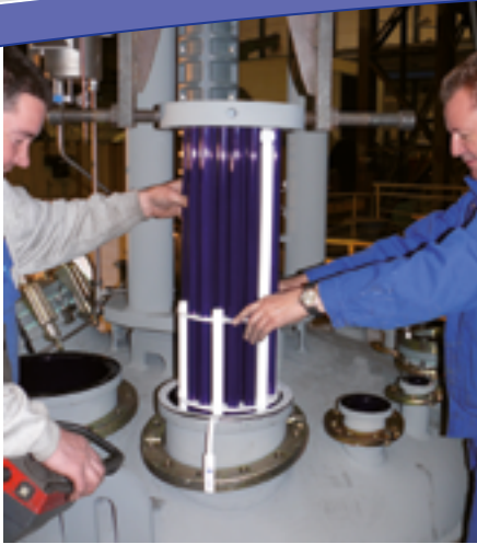
Einsetzen eines WTU-Kompaktwärmetauschers (PowerBaffle) in einen emallierten Rührbehälter
